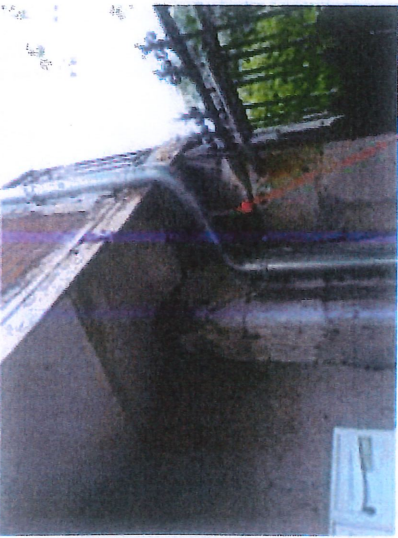
11 12 QUAI PORTILION CHANAGE A CONSOLIDER LEZARDE A SURVEILLER (POSE DE TEMOINS)
